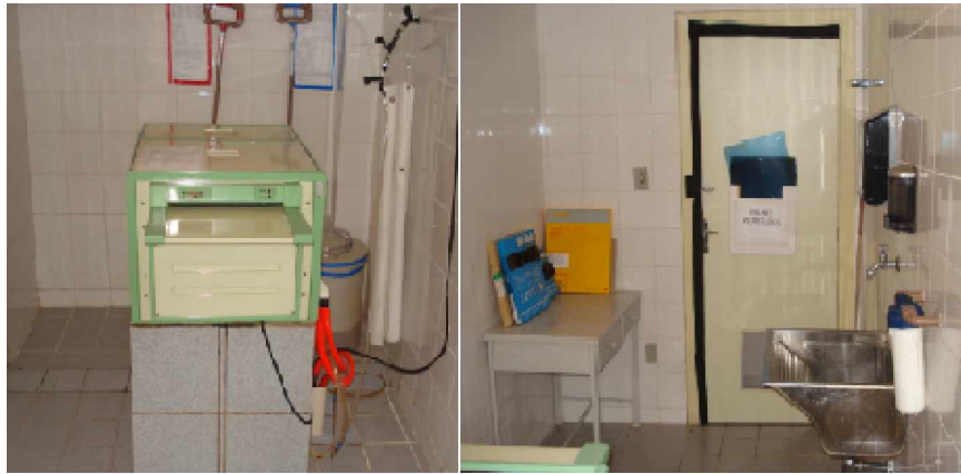
Figura 4.1. Câmara escura do hospital A. A primeira foto mostra a entrada da processadora e a segunda apresenta um tanque existente na sala e a porta com vedação para luz externa.
